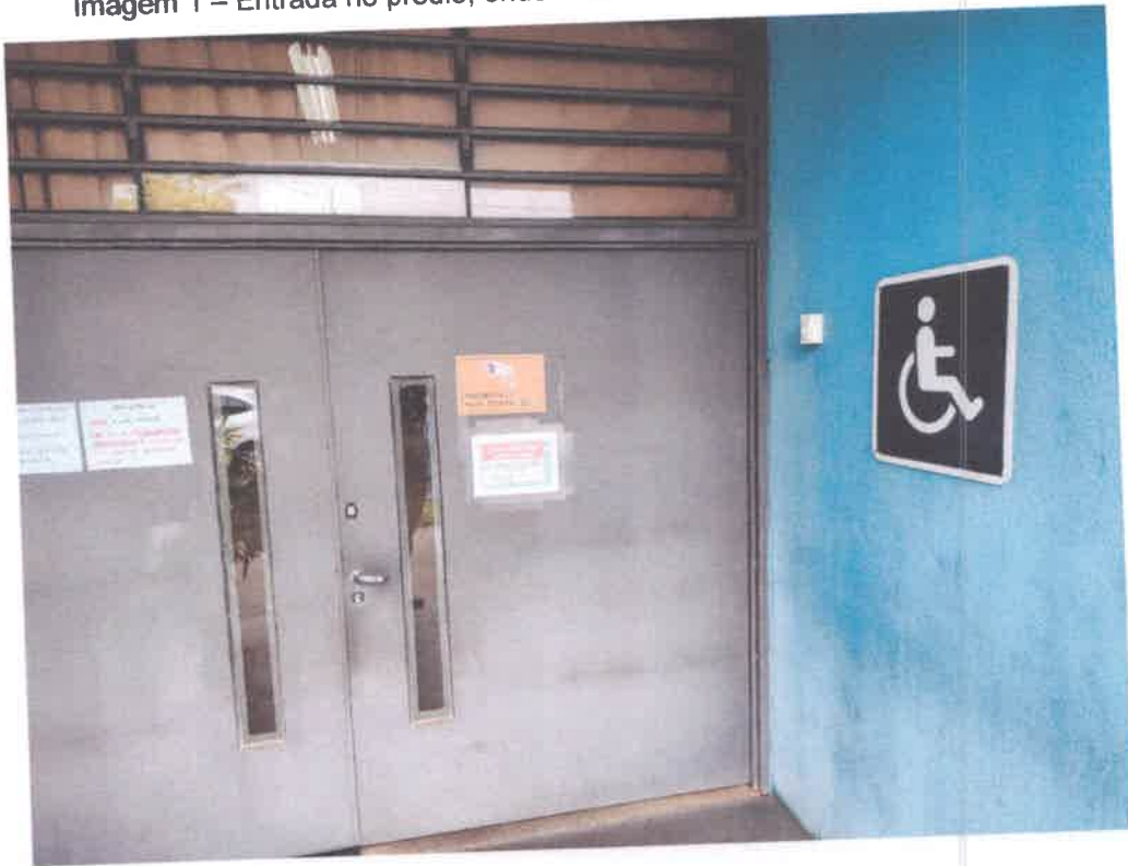
Imagem 1 – Entrada no prédio, onde é informada a acessibilidade do local
