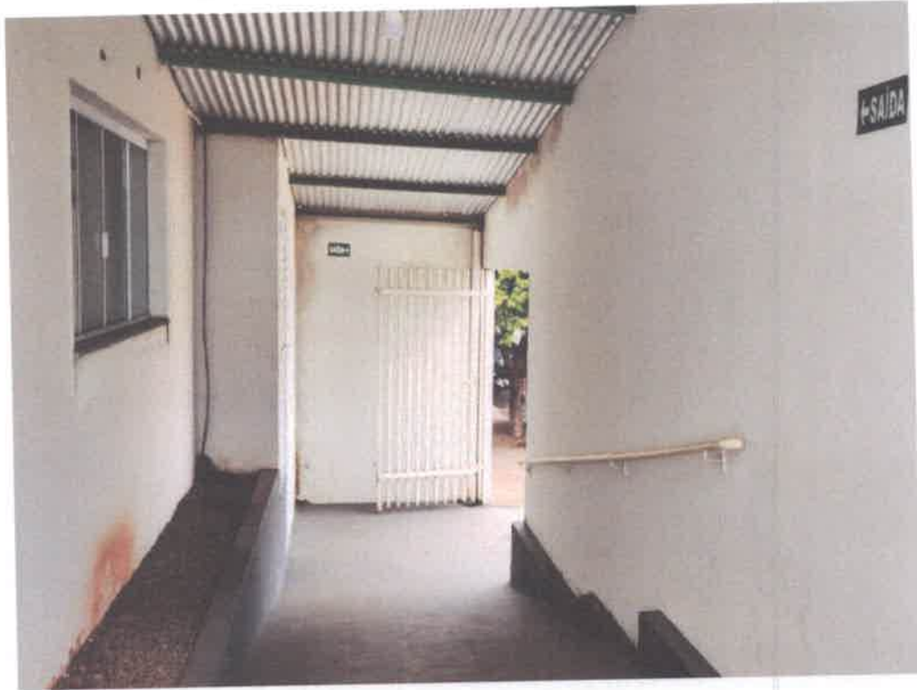
Imagem 11 – Entrada de Emergência para ambulâncias
